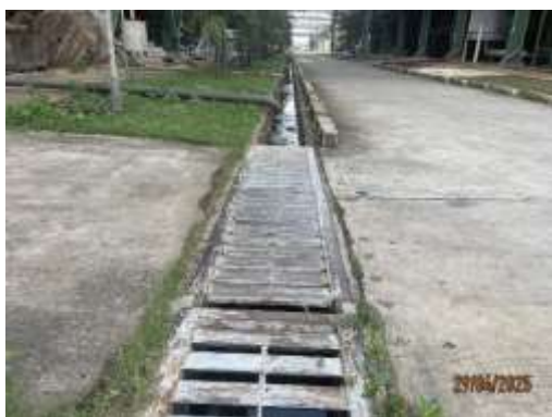
รูปที่ 32 วางระบายน้ำฝนภายในพื้นที่โครงการ
