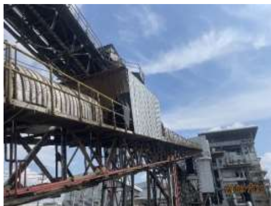
รูปที่ 3 ระบบสายพานลำเลียงกากอ้อยแบบปิด
