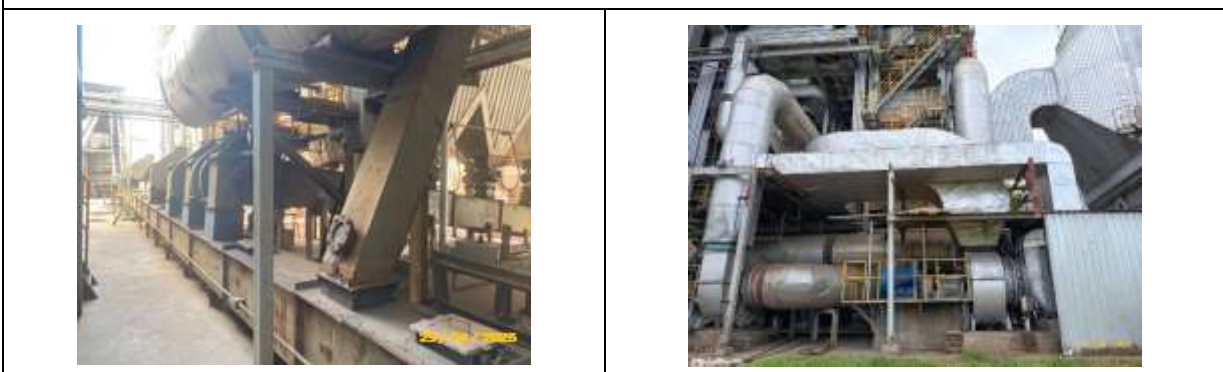
รูปที่ 23 เครื่องจักรที่มีการปิดครอบและเว้นวางเพื่อลดระดับเสียงและการสั่นสะเทือน
